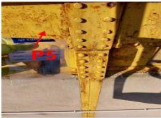
a Prelevement_005 Présence d'amiante Extérieur - Toiture Test lingette sur poutre métallique
